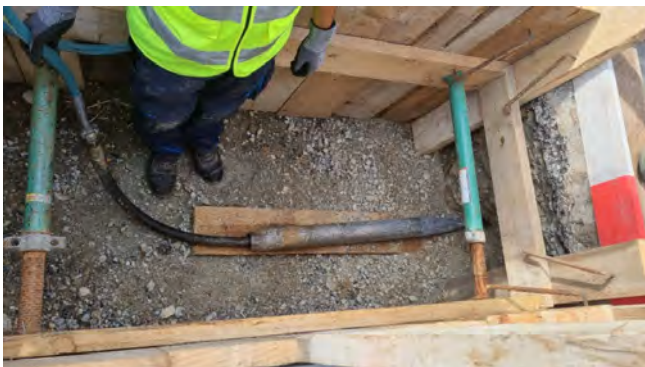
Abb. 1. Bohrung mit Erdrakete (links) und das zugehörige Messsignal (rechts)
